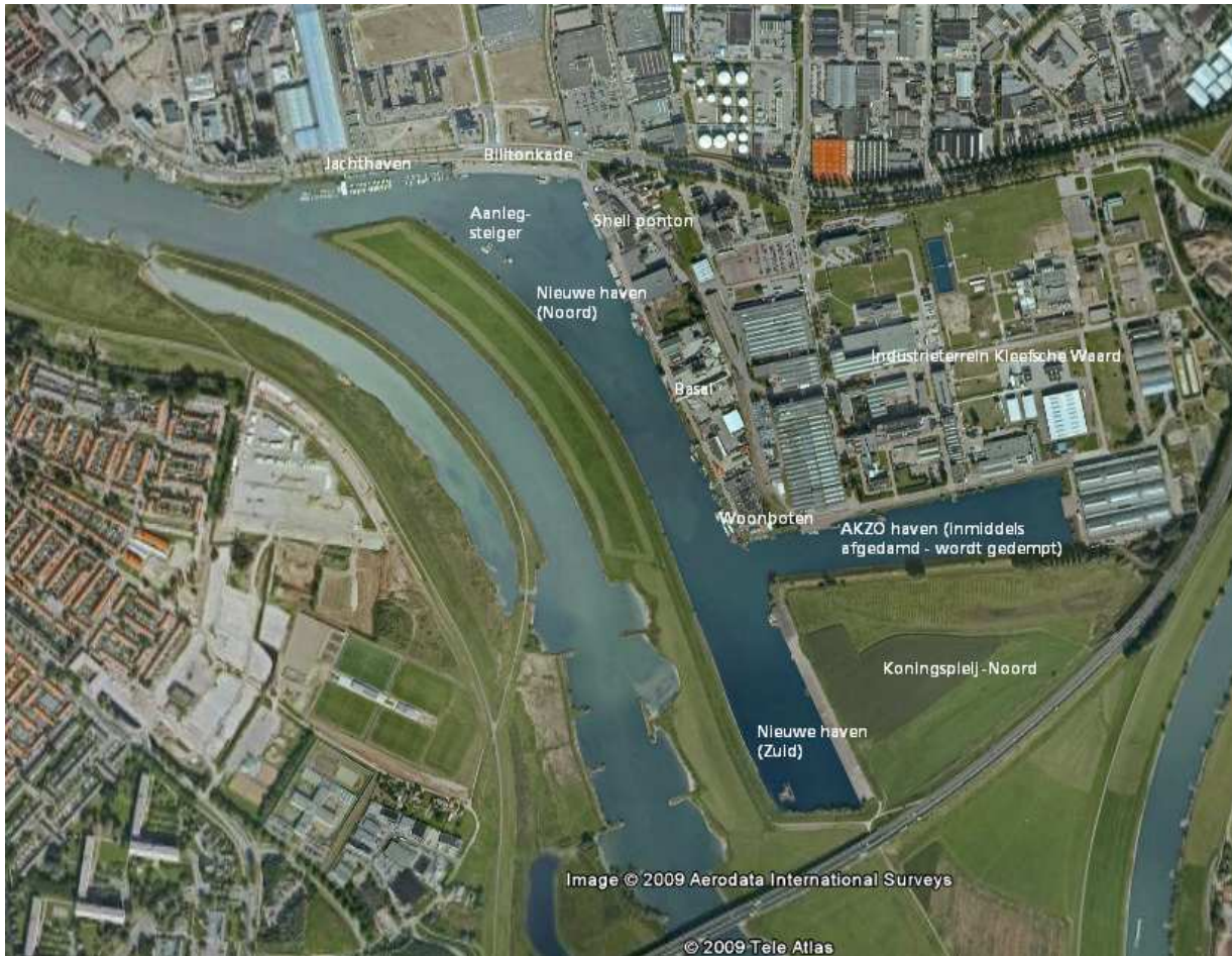
Figuur 1: Situatie Malburgerhaven (bron: Google Earth)
