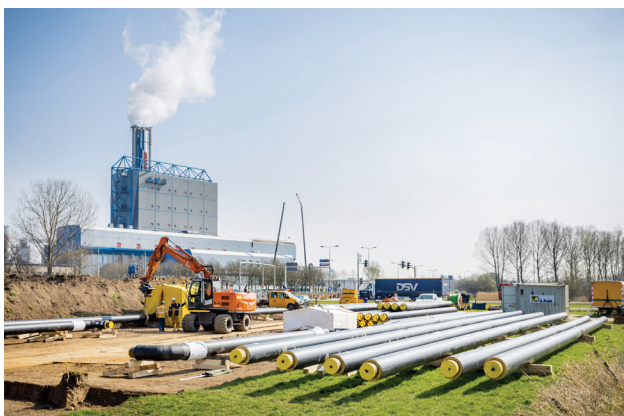
Aantakking warmtenet op AVR Duiven
